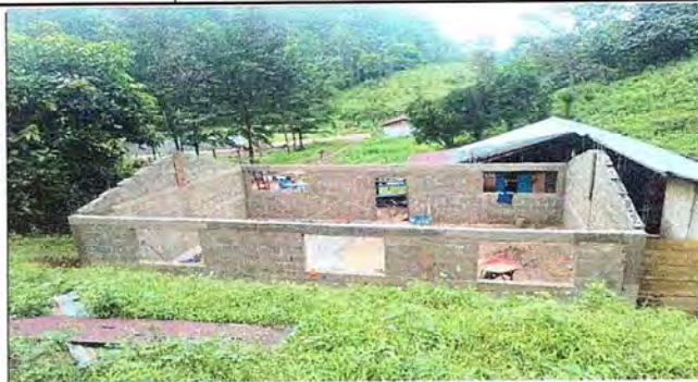
Foto 2: Mejoramiento de las paredes que estaban en mal estado.
