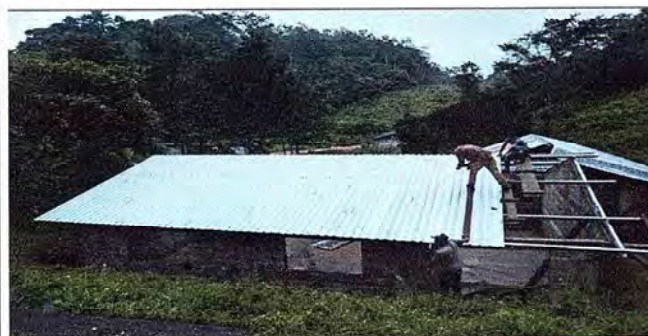
Foto 5: Cambio de las láminas que estaban deterioradas por láminas troqueladas.
