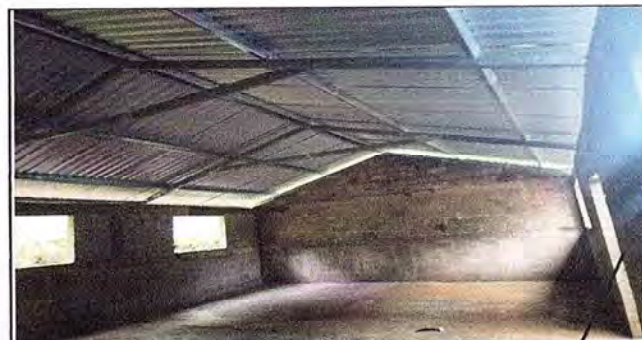
Foto 4: Mejoramiento del piso del aula que estaba deteriorada, por piso nuevo.
