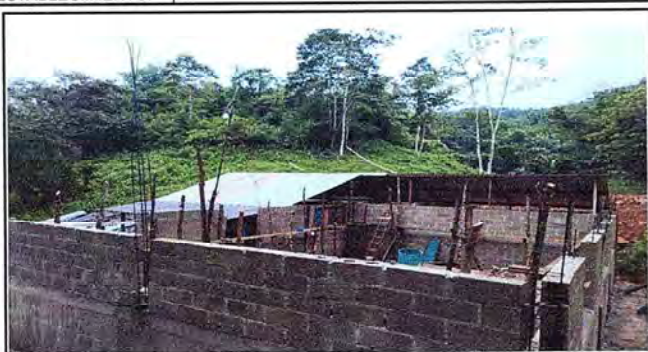
Foto 1: Reforzamiento de las columnas que estaban deterioradas por las inclemencias del tiempo.
