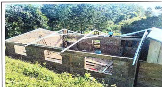
Foto 3: Cambio de las vigas de madera por costaneras
